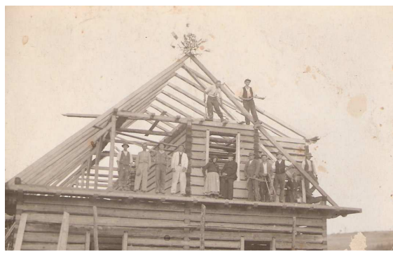
Fot.5. Zdjęcia z budowy nowej plebani Osoby stojące w centrum, obok okna to ks. Góralik i jego mama
